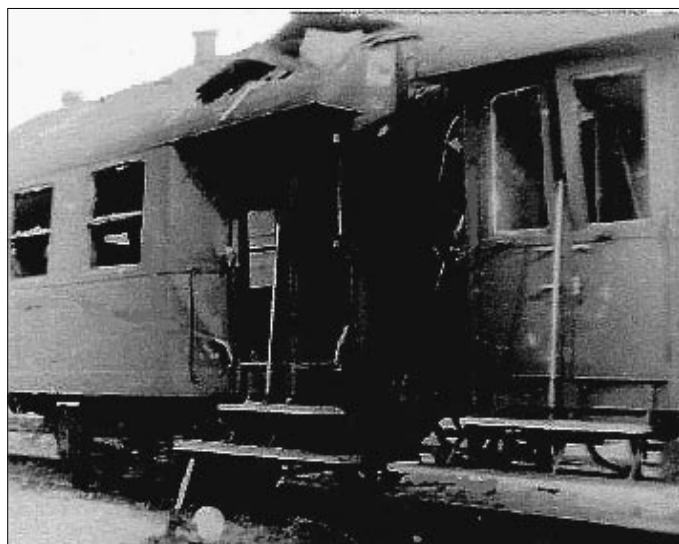
Terrorsprængning af passagertog ved Lillerød d. 27.07.1944.
